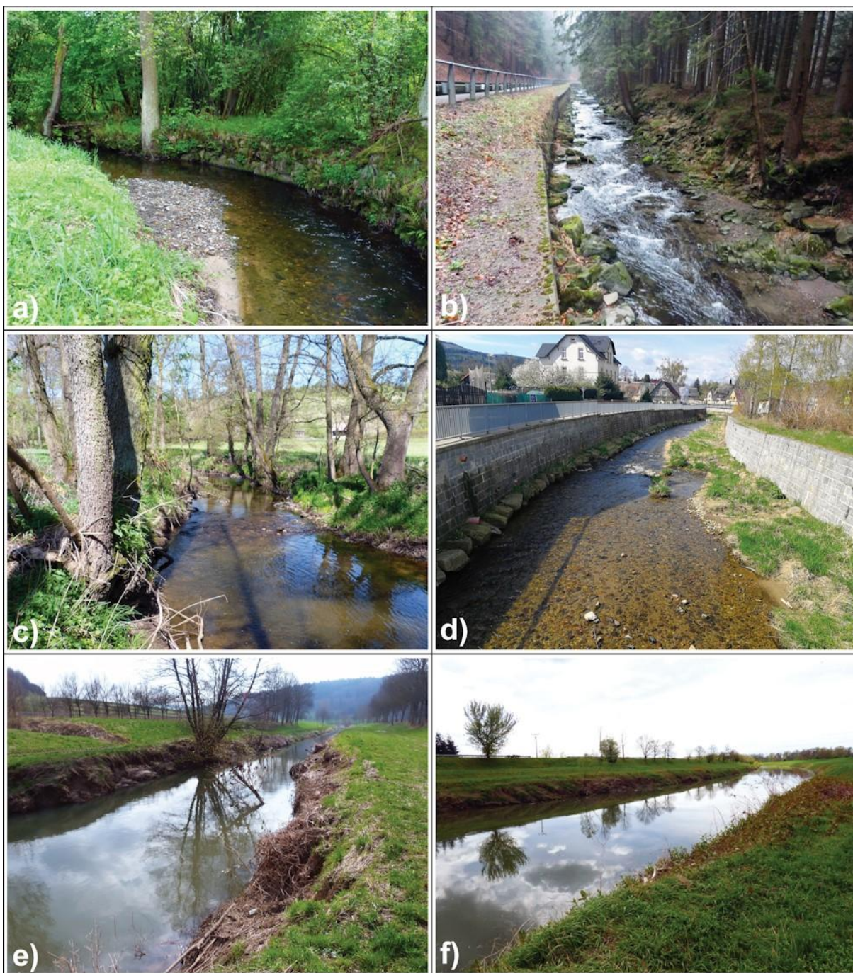
Obr. 45: Příklady antropogenně snížené variability koryta, (a) variabilita příčného profilu je snížena starými stabilizacemi břehů, které se vyskytují pravidelně na více místech v rámci hodnoceného úseku (na 20 %), hodnoceno kategorií 2; (b) variabilita příčného profilu je snížena kvůli stabilizaci pravého břehu na délce více než 33 %, přičemž variabilita hloubek a levého břehu je zachována, hodnoceno kategorií 2; (c) příčný profil byl v minulosti upraven do lichoběžníkového tvaru, variabilita hloubek je částečně zachována a zlepšována dřevinou vegetací, hodnoceno kategorií 3 a odečteny 3 body za částečné zachování variability; (d) upravený příčný profil, v korytě se nacházejí lavice, které zvyšují variabilitu, hodnoceno kategorií 3 a odečteny 3 body za částečné zachování variability; (e, f) příčný profil je silně ovlivněn, hodnoceno kategorií 3 (v případě toku na obr. (e) dochází místy k erozi břehů, která ovšem zatím nevede ke zvýšení variability hloubky nebo šířky koryta)
