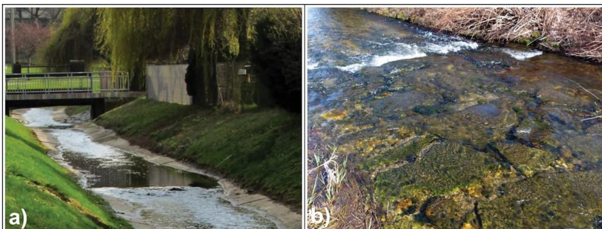
Obr. 10: (a) betonové panely tvoří nepropustnou vrstvu, která narušuje vertikální kontinuitu; (b) ačkoliv kamenná dlažba bez pojiva významně mění charakter dna, není nepropustným typem stabilizace, tzn. dochází jenom k částečnému narušení vertikální kontinuity
