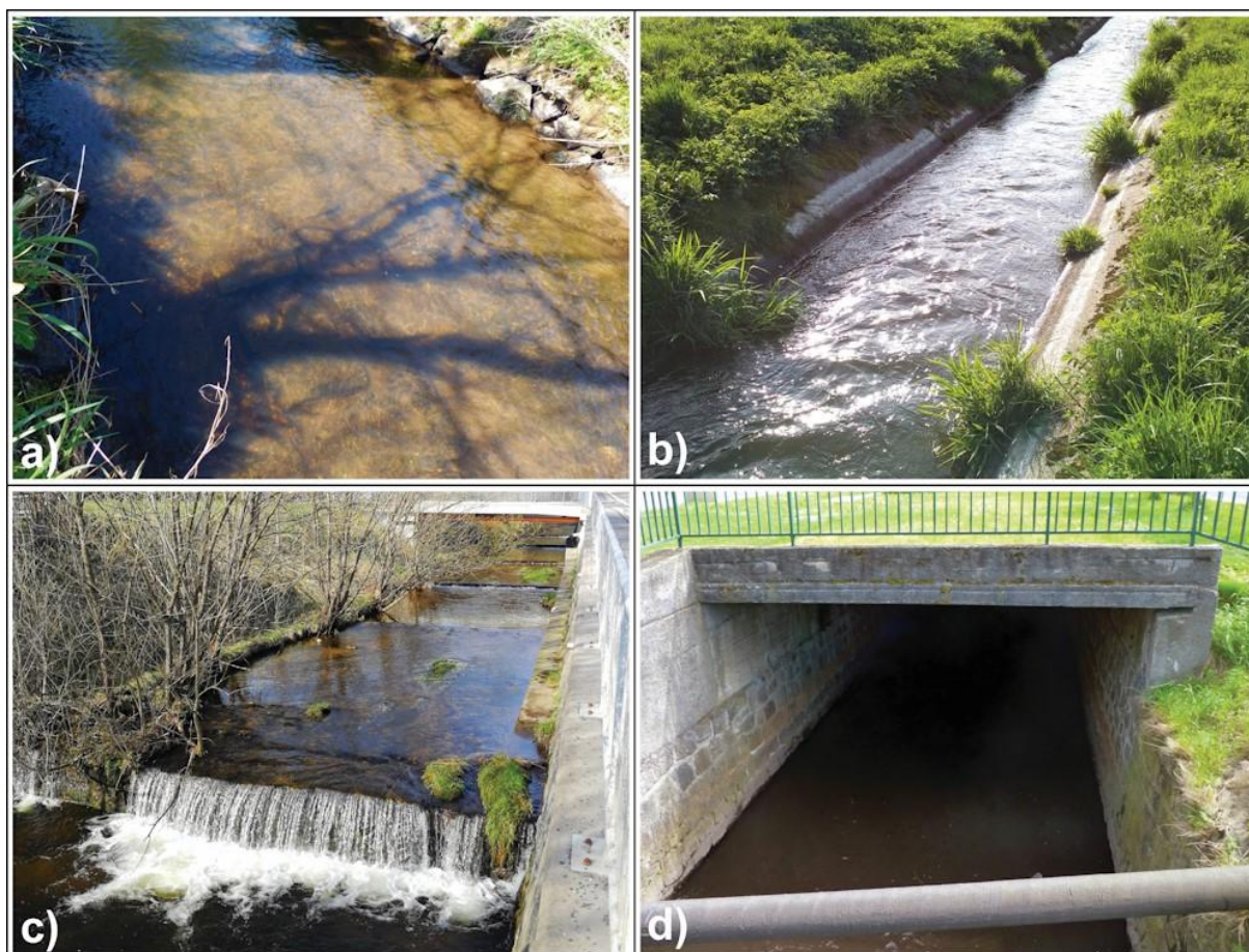
Obr. 46: (a) stabilizace dna koryta pomocí kamenné dlažby; (b) stabilizace břehů a dna betonovými panely představují tvrdý typ stabilizace; (c) stabilizační stupně a prahy významným způsobem mění morfologii dna koryta; (d) zakryté vodní toky nejsou schopny plnit ekologické funkce
