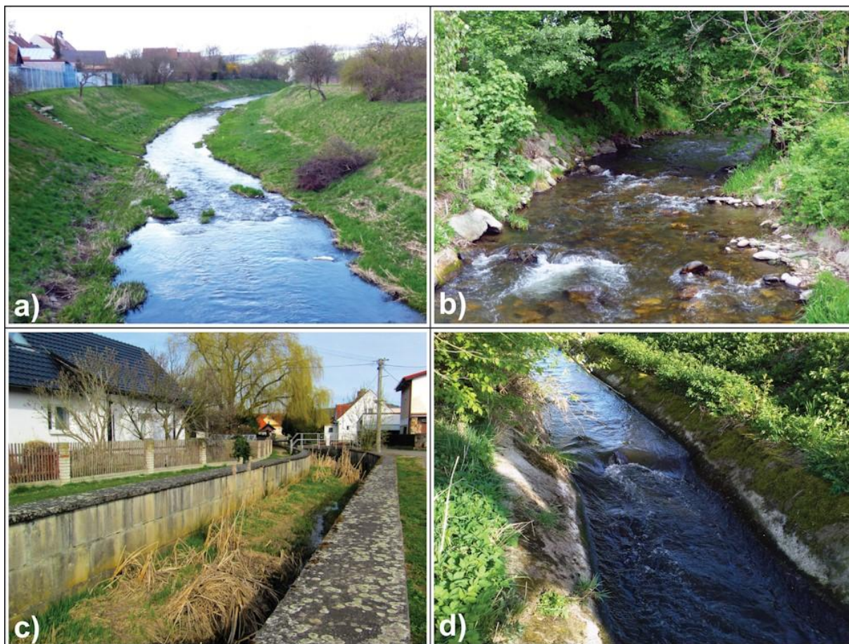
Obr. 47: Stabilizace zatravněním (a) a kamenným záhozem (b); kamenné zdi (c) a betonové panely (d) patří mezi tvrdé stabilizace, kterým jsou přirazeny dodatečné body
